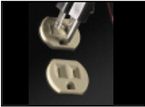
115 Volt AC Auxiliary Power
