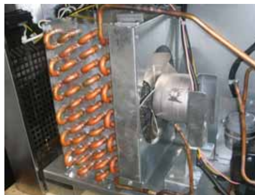
CONDENSER FAN MOTOR ASSEMBLY TCBE-82SDR/TCBE-96SDR
