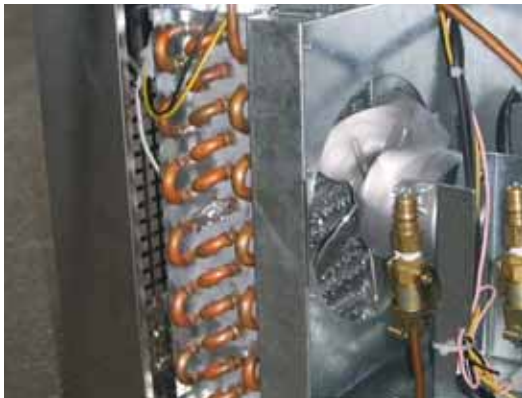
CONDENSER FAN MOTOR ASSEMBLY TCBE-52SDR
