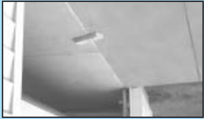
FIG. 6-5 Vis de réglage de la force de la porte.
