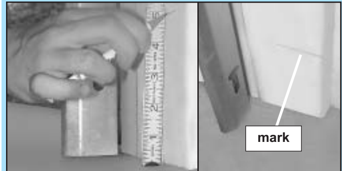
FIG. 3-1 Mark door frame.
